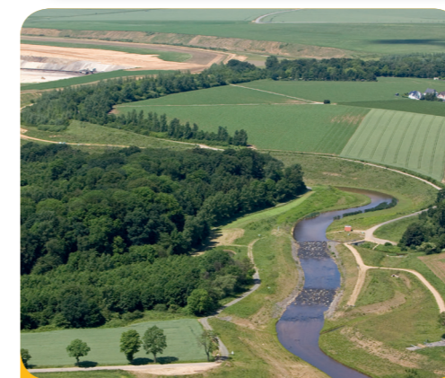
Abb. 6: Hier musste der ganze Fluss, die Inde, verlegt werden.
