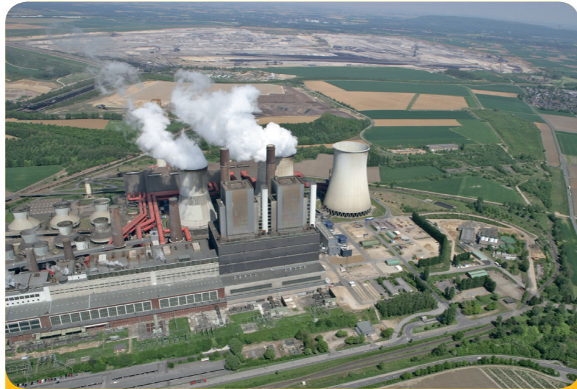
Abb. 1: Vorne das Kraftwerk Weisweiler, das man von der Autobahn A4 Aachen-Köln sieht. Hier wird aus Braunkohle Strom gemacht – die „Wolken“ sind kein Rauch, sondern Wasserdampf. Im Hintergrund das große Tagebauloch.
