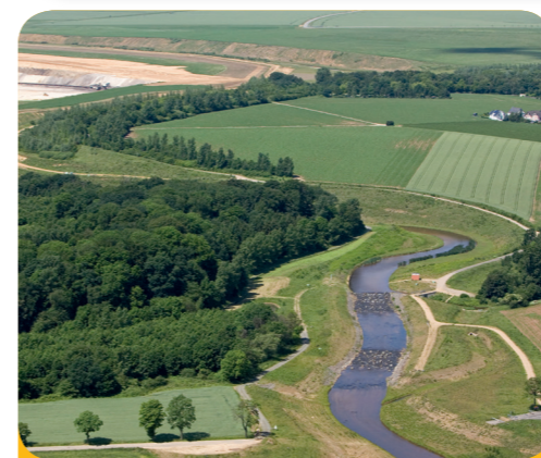
Afb. 6 - Hier moest de hele rivier, de "Inde", worden verlegd.
