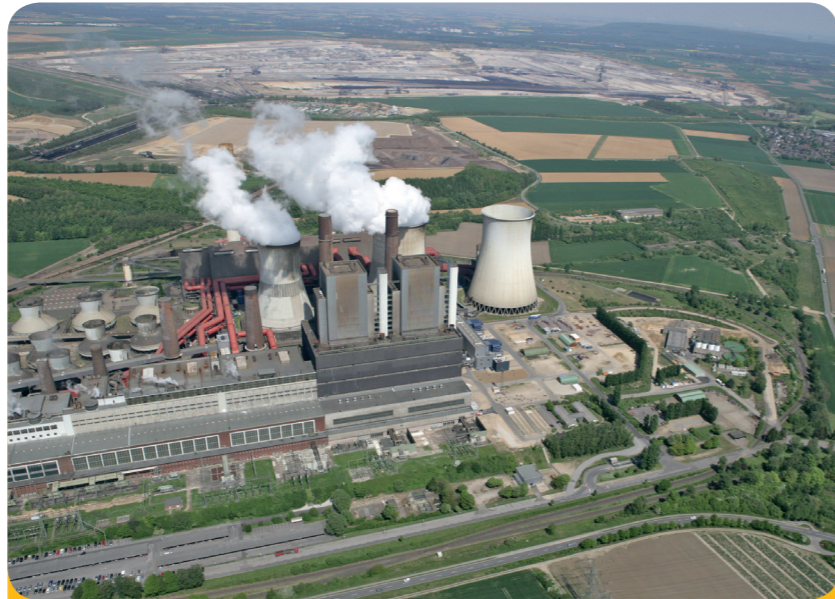
Afb. 1 - Op de voorgrond de elektriciteitscentrale "Kraftwerk Weisweiler", zichtbaar vanaf de A4 Aken-Keulen. Hier wordt stroom opgewekt uit bruinkool: de "wolken" zijn geen rook, maar waterdamp. Op de achtergrond het grote dagbouwgat.
